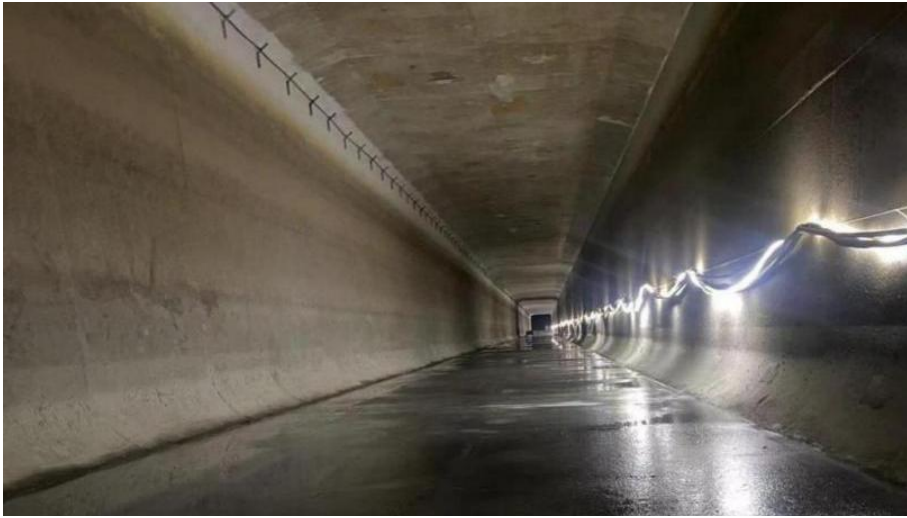
▲深圳水库渡槽底板抗冲磨修复
