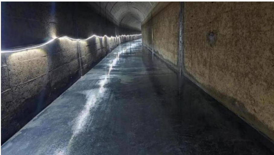
▲西河潭隧道底板抗冲磨修复
